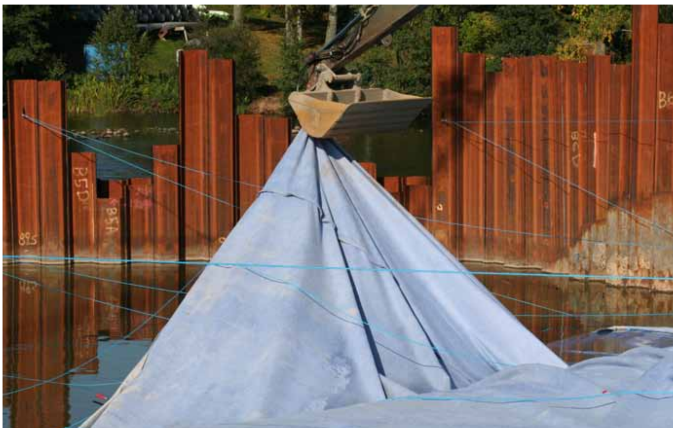
Figur 7.12: Utläggning av geotextil vid udden
