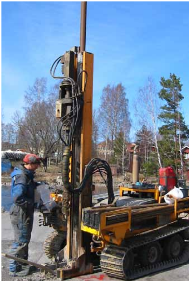
Figur 6.5: Provbörning med skruvborr
