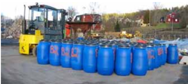
Figur 7.13: Uppställda fyllda plasttunnor med jord och metalliskt kvicksilver med högst halter föroreningar
