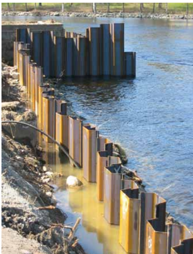
Figur 7.2: Till vänster är den färdiga skyddssponten med slang till pump. Nere till höger anläggs dränering längs Strömgatan och skissen ovanför visar spontens profil
