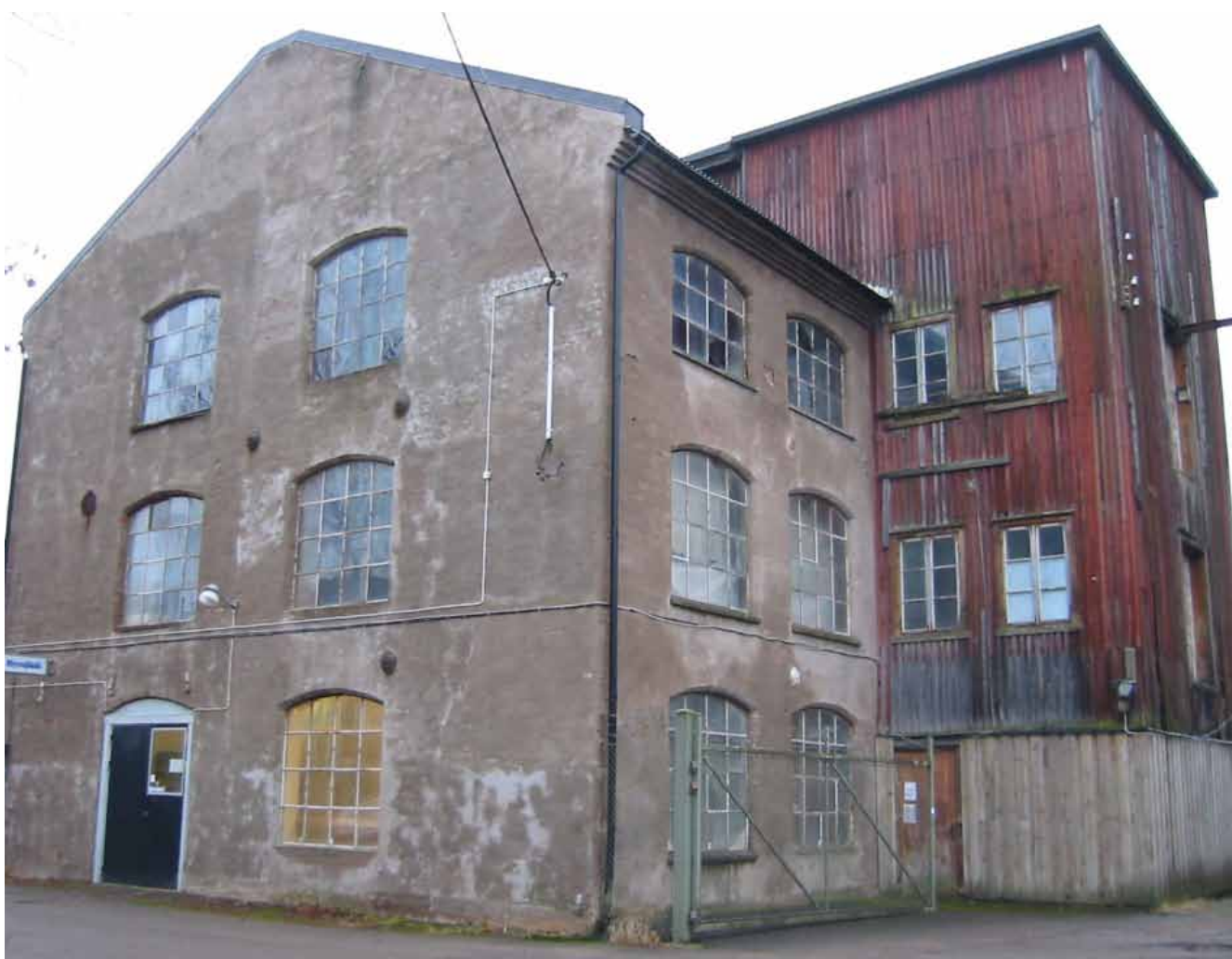
Figur 3.1: Tornet och lagret (Byggnad A) 2004, strax innan rivning
