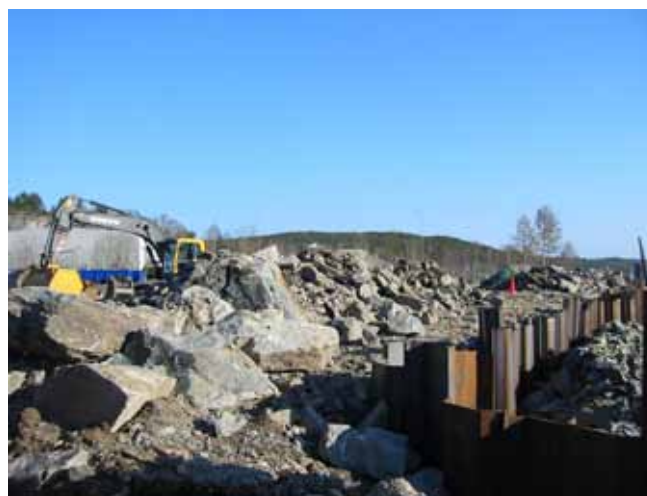
Figur 7.5: Schaktningsarbeten på EKA-tomten 2007/2008
