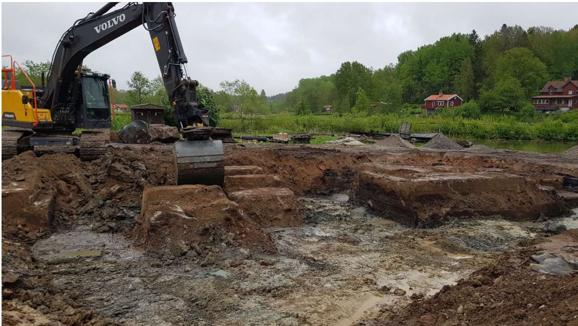
Figur 5 Schakt i f.d. såghusets botten med betongfundament.
