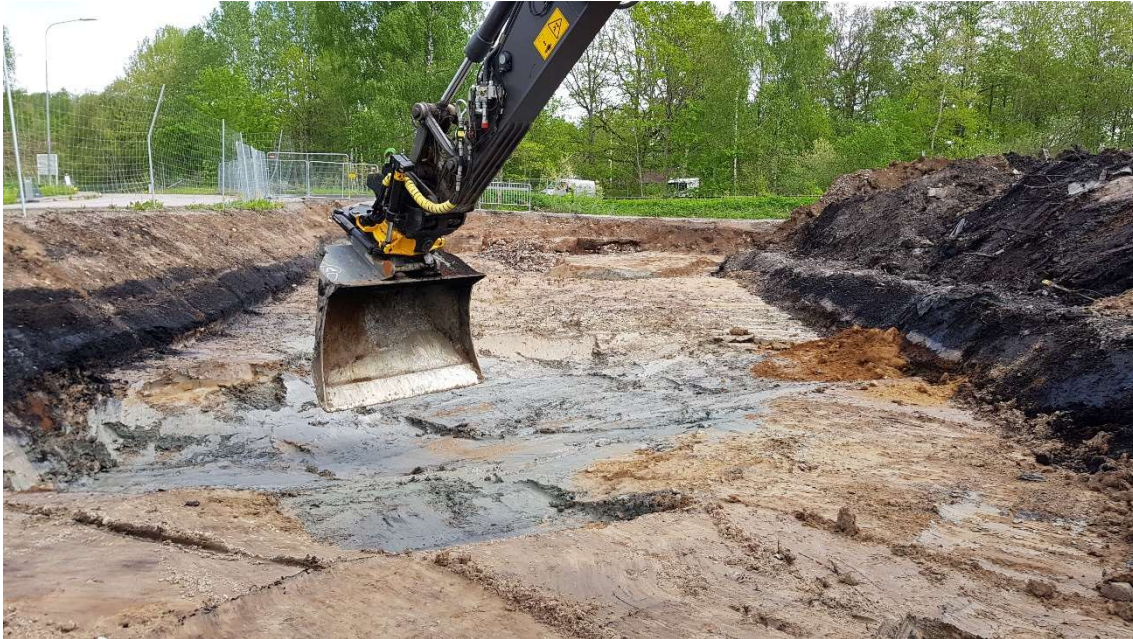
Figur 6 Schakt mellan Sågvägen och söderut på sågverksområdet. Till höger syns uppschaktade massor inför utleverans. Till vänster syns det svarta förorenade skiktet som lämnats kvar under Sågvägen.
