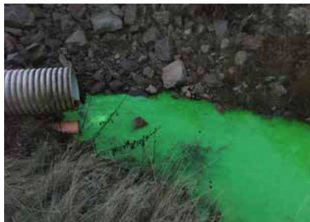
Vatten från lakvattendammen läckte ut i utlopp nedströms deponin. Foto: Oskarshamns kommun
