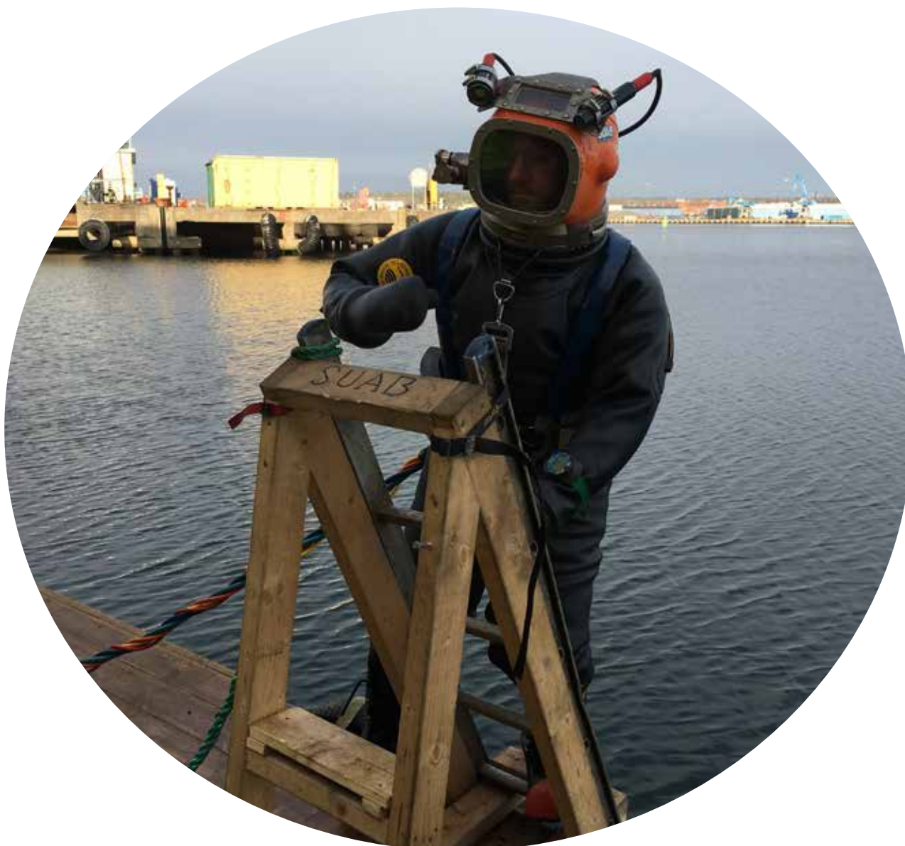
Dykning för att kontrollera sediment. Foto: Oskarshamns kommun
