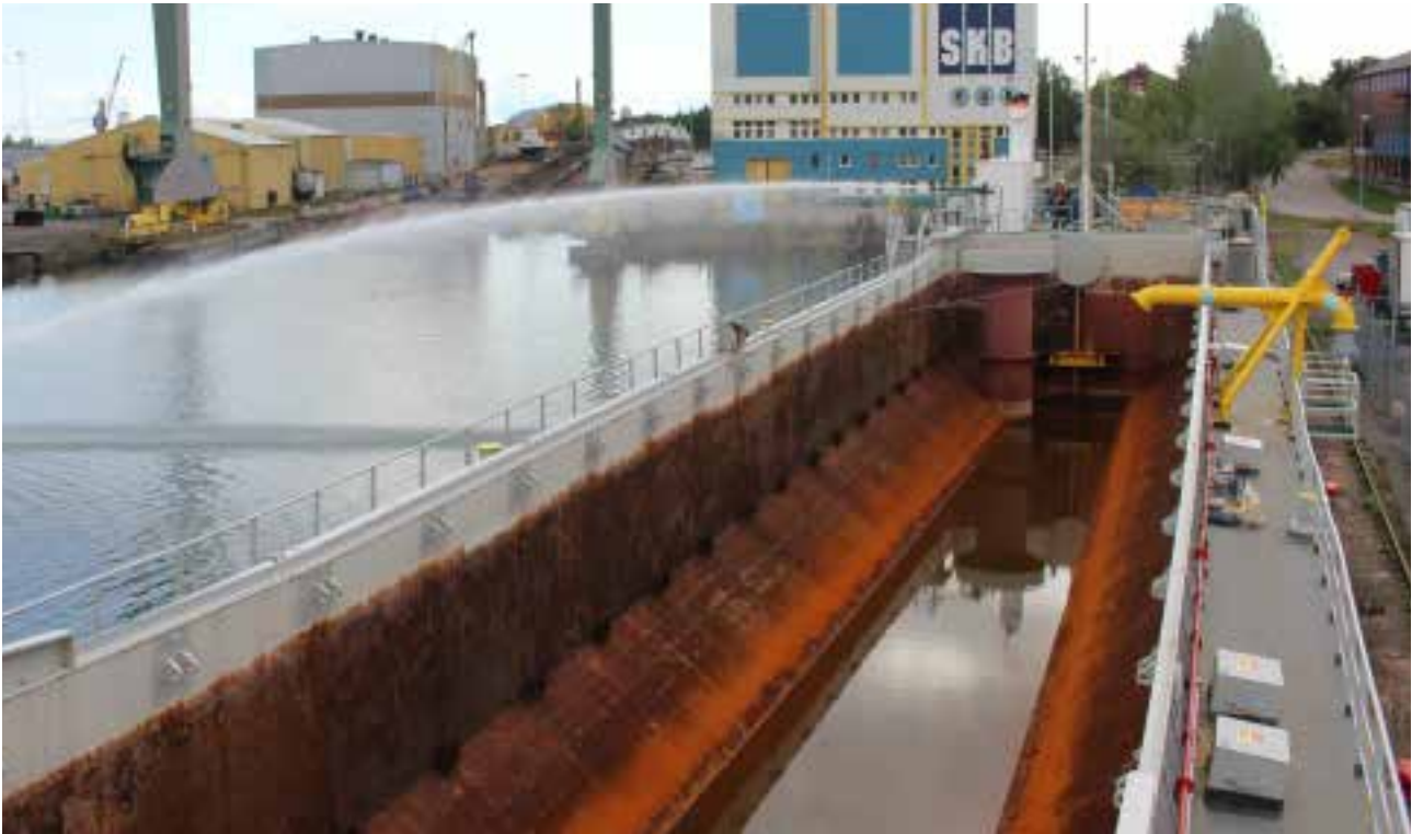
Provtryck av pråmen Weseltje inför uppstart av muddring hösten 2016. Foto: Oskarshamns kommun
