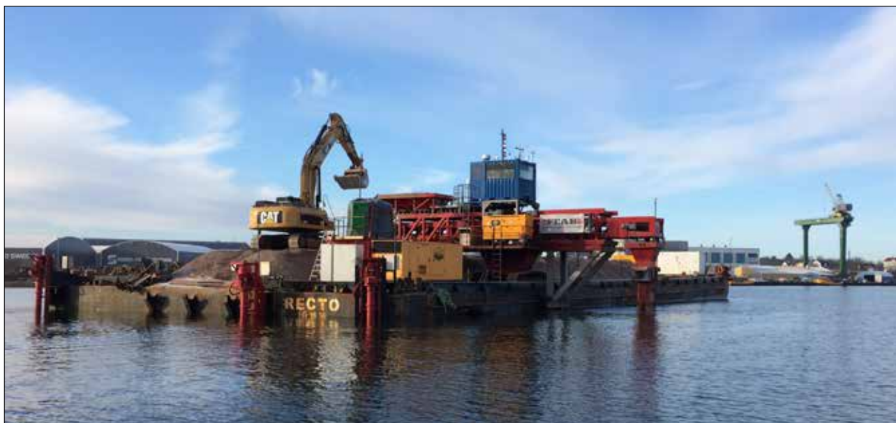
Avslutande åtgärder med täckning. Foto: Oskarshamns kommun
