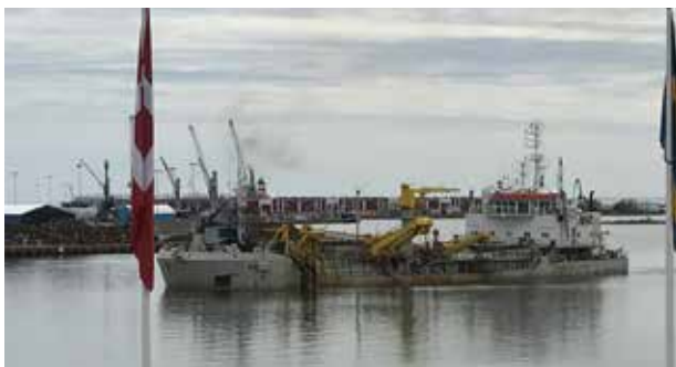
Mudderverket Pinta muddrar i inre hamnbassängen. Foto: Oskarshamns kommun
