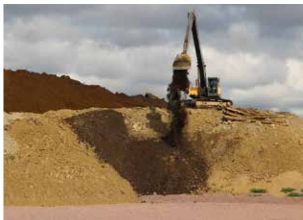
Exempel på dammande verksamhet. Dammbekämpning kom att utföras genom ett sprinklersystem runt deponin. Foto: Oskashamns kommun
