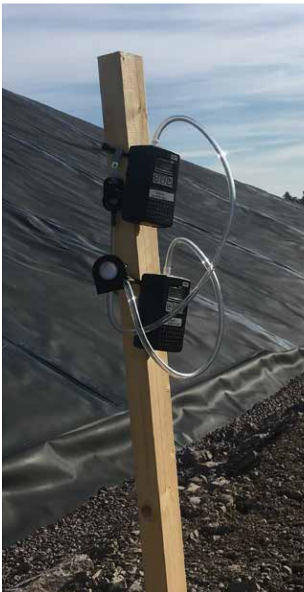
Luftprovtagning för att mäta damm vid projektets deponi vid Storskogen. Foto: Oskarshamns kommun
