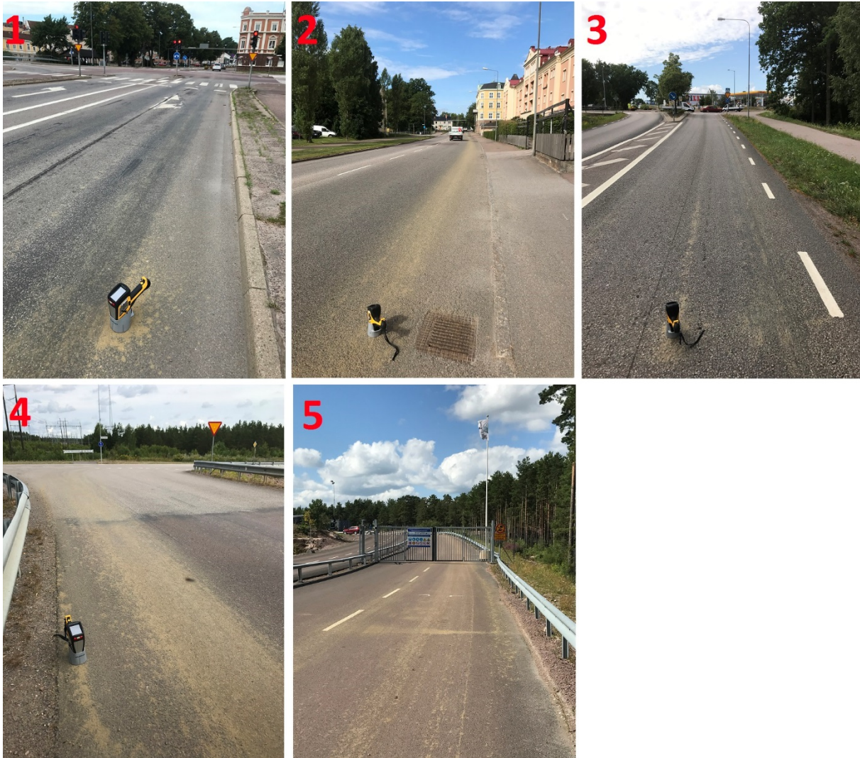
Figur 1 Foton av vägvagnsnitt innan sanering (27/7 2017).
