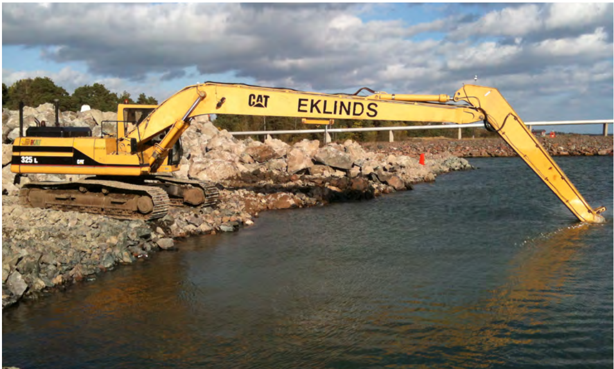
Figur 8.2 Rena sediment schaktas inför utbyggnad av kantvall mot oljehamnen. Foto: Göran Nilsson, Faveo Projektledning AB.
