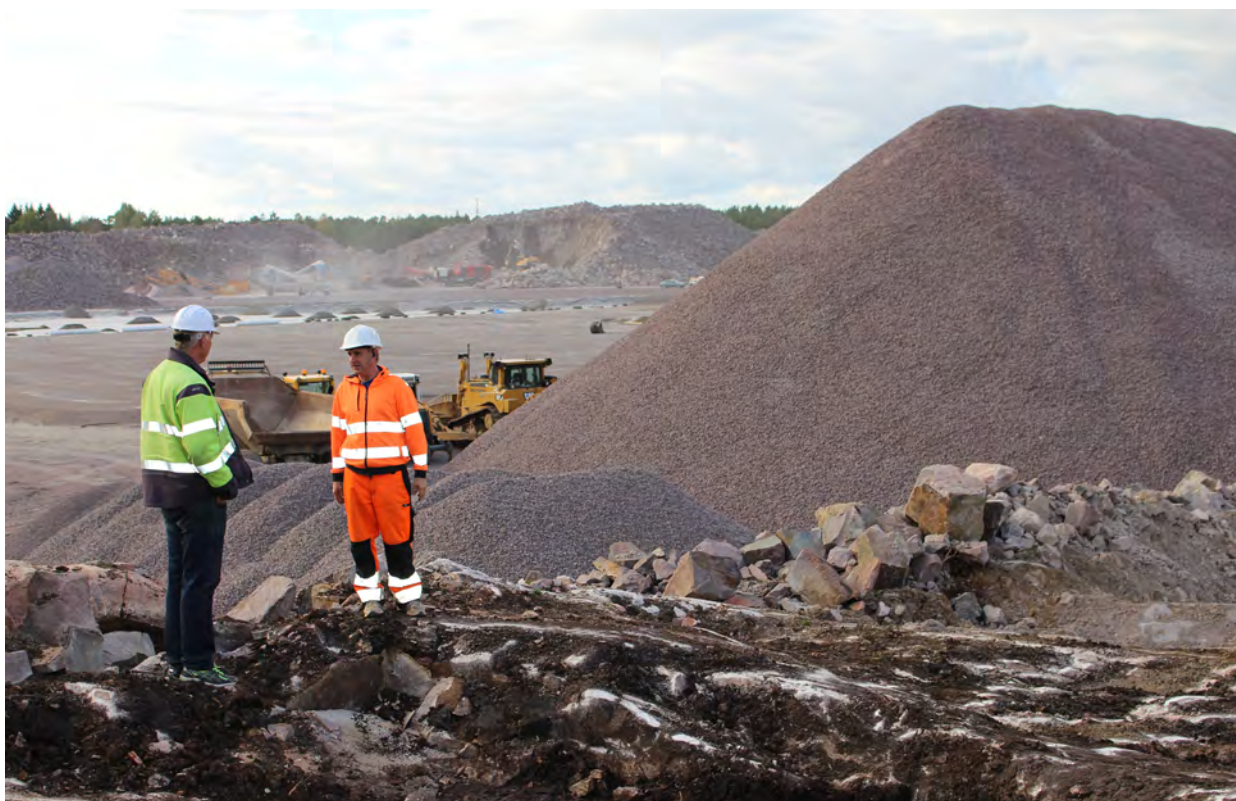
Figur 8.3 Anläggning av Storskogens deponi. Foto: Anna Kinch, Oskarshamns Kommun.
