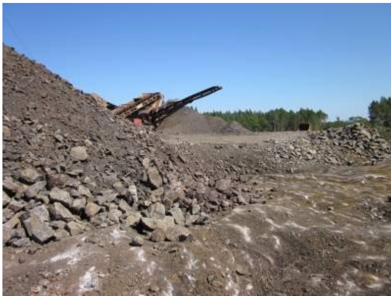
Bild 1. Sorteringsverk vid saneringsentreprenaden av Gladhammars gruvor. Foto: Ulrika Palmér, Empirikon Konsult AB
