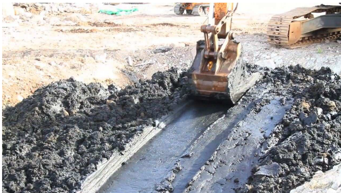
Figur 12 Provschaktning i bassäng 2. Skede 1 uppbyggnad av slänt i lutning ca 1:4.
