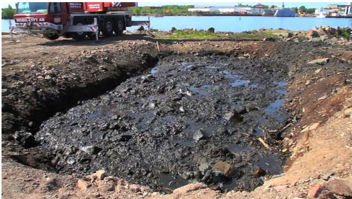
Figur 10 Bassäng 2 fylld med muddermassor.
