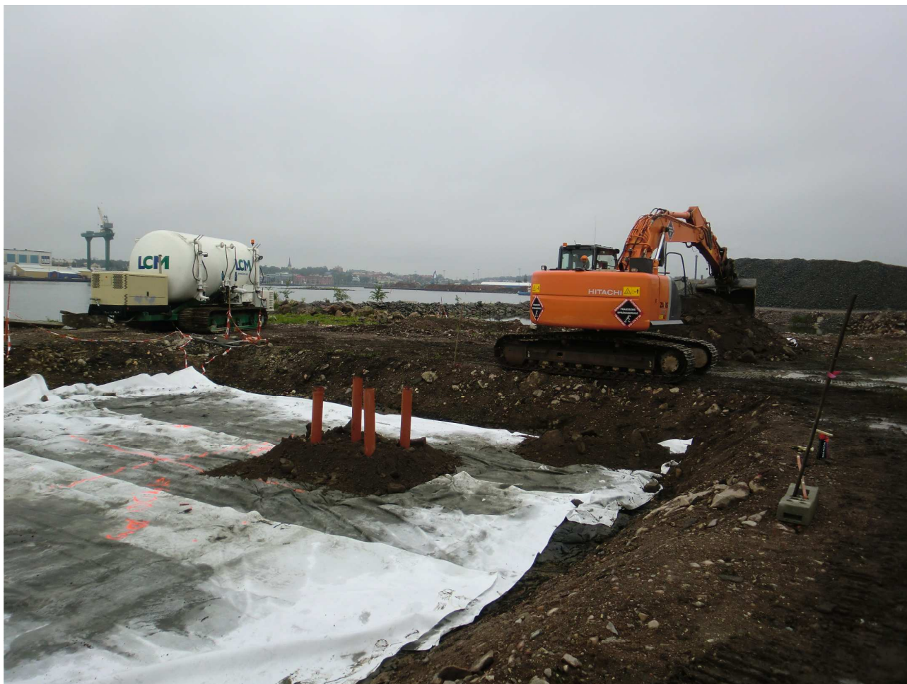
Figur 8 Uppbyggnad av mätstation delyta 1.
