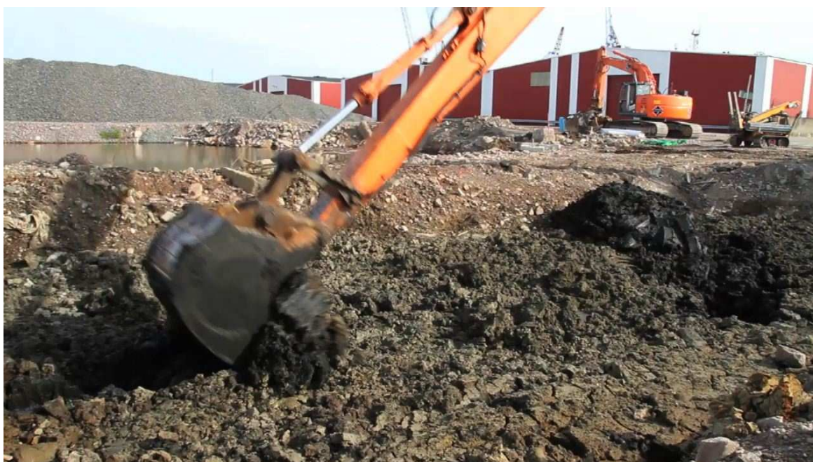
Figur 11 Provschaktning i bassäng 2. Skede 1 med en skyddszon mot vatteninträngning.
