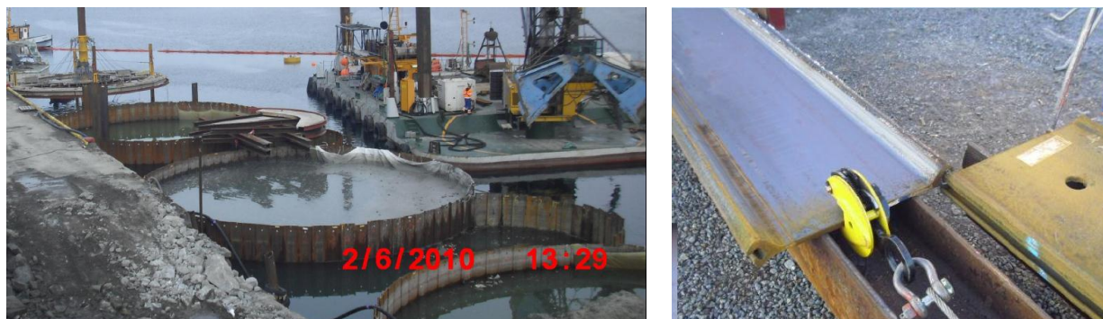
Figur 6 Exempel på cellspont under uppbyggnad, med detalj på spontlås.
