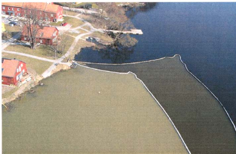
Figur 12. Avskärmning med dubbla geotextilier, Järsla sjö i Stockholm.
